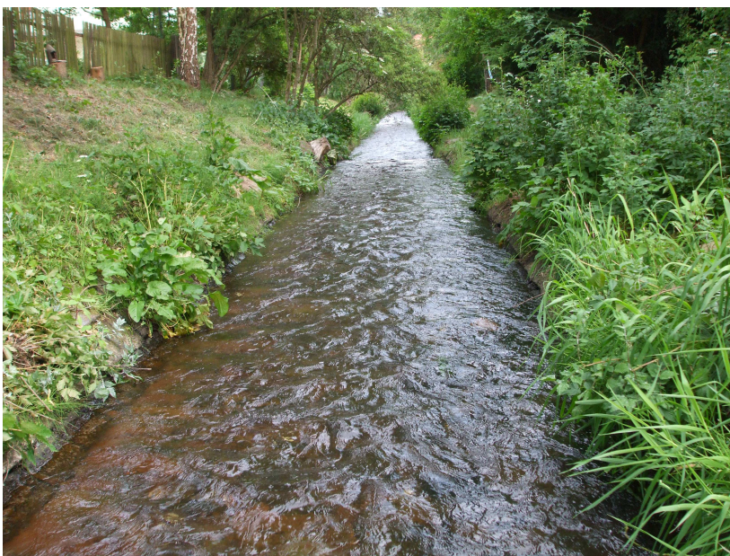
Abb. 2: Begradigte und ausgebaute Lohr im Ortsbereich von Frammersbach
