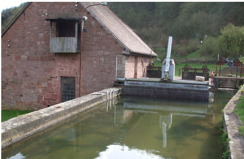
Abb. 5: Einlaufbereich zu den beiden Turbinen am „Oberen Eisenhammer“ in Lohr
