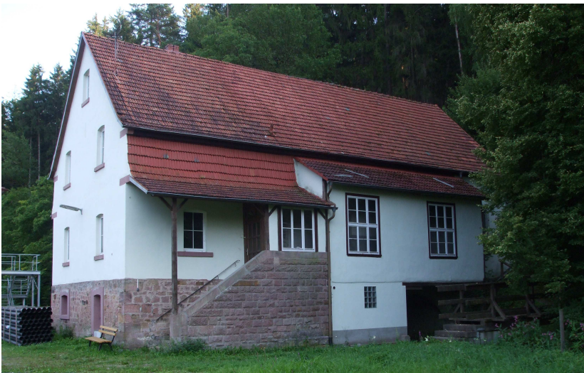
Abb. 7: Elektrizitätswerk Frammersbach, bis in die 1960er Jahre bewohnt vom gemeindlichen „E-Werker“ mit seiner Familie, er betreute die Anlage ganzjährig rund um die Uhr. Heute steht die Wohnung leer.
