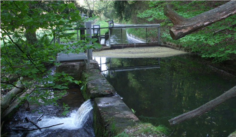
Abb. 4: Wehranlage an der Lohr etwa 1,3 Kilometer oberhalb von Partenstein in Richtung Frammersbach mit Abzweig des Triebwerkskanales zur früheren Schleifmühle, heute Stromerzeugung mittels einer Turbine
