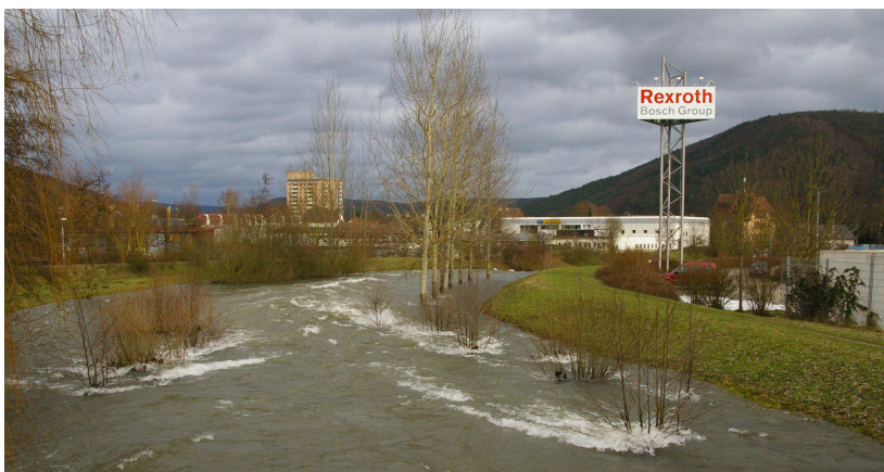
Abb. 3: Zwanzigjähriges Hochwasser in der 1998 errichteten neuen Flutmulde der Lohr im Januar 2011
